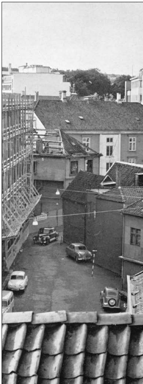
Bredalbygget under oppføring. I bakgrunnen Den Kombinerte Indretning. Foto: Olav Ellingsen – Stavanger kommune – fra Per Anderssons «Stavanger i støpeskjeen».
