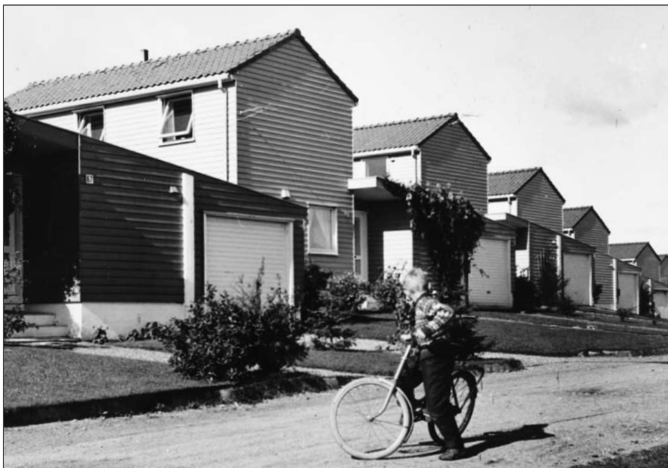
Kjedehus, Auglendsveien. Foto: Stavanger Boligbyggelag Attached houses, Auglendsveien.
