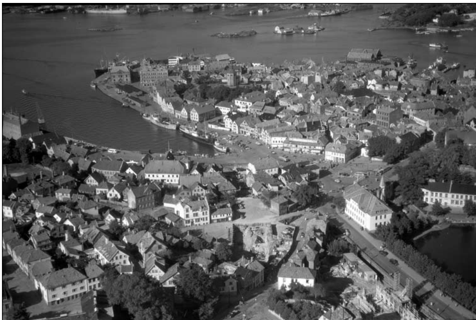
Stavanger sentrum, september 1948: Nederst til høyre Atlantic Hotel under oppføring. Saneringen i Kleiva har startet. Olav Kyrresgate helt til venstre. Foto: Widerøe – Byarkivet i Stavanger
